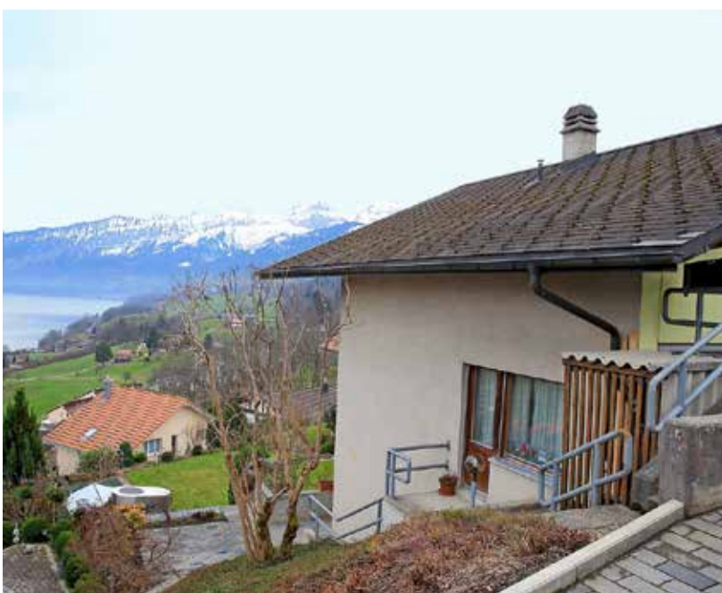
Im Einfamilienhaus der Familie Wildhaber wurde die Elektro Speicherheizung durch eine Wärmepumpe ersetzt.
